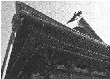
⑦天井なし丸木極の化粧屋根裏
