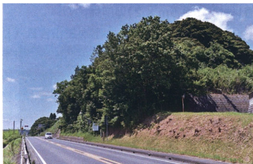
国道51号線からの全景
